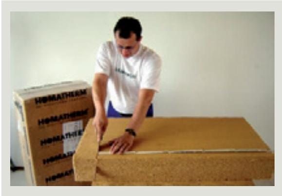
La protection contre les chaleurs estivales est l'un des points forts des isolants en fibre de bois en comparaison avec les isolants habituellement utilisés. Cette protection est obtenue en rallongeant le déphasage (temps de passage de la chaleur à travers une cloison).
